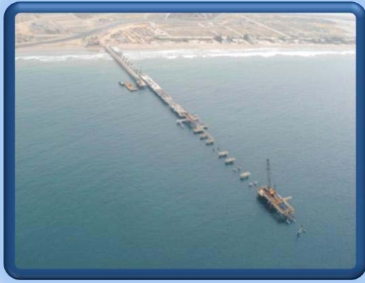
PLANTA DE ALMACENAMIENTO DE GAS LIVIANO DE PETROLEO
